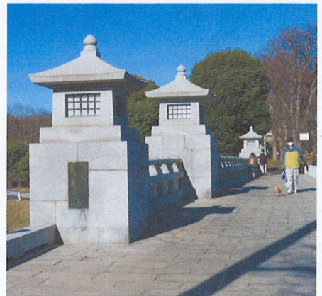
補修、洗浄作業で生まれ変わった御陵橋
